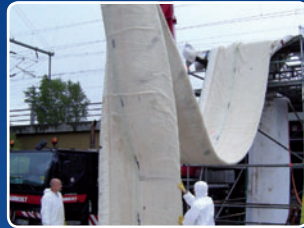
Prüfung von Schlauchliner (NF / GFK) bis zu DN 1200
